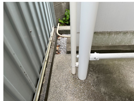
雨樋のパイプ下への破損なし
